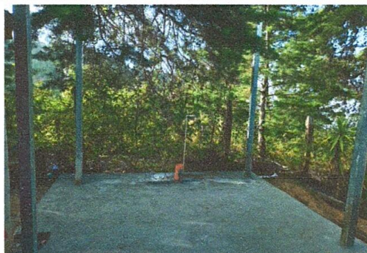
Foto 4: Mejoramiento de galera para pila.
