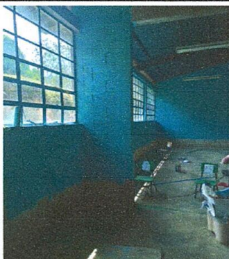
Foto 3: Mejoramiento de Pintura de Aula Polifuncional, interior y exterior.
